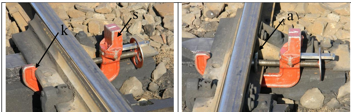
Rys. 3 Zabezpieczenie iglicy dosuniętej
